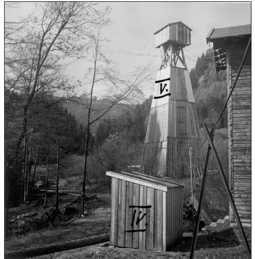
Das Foto wurde von der Ölkapelle aus nach SW aufgenommen. Es zeigt die Lokation Rohbogen 4 vor dem Bohrturm auf der Rohbogen 5.
